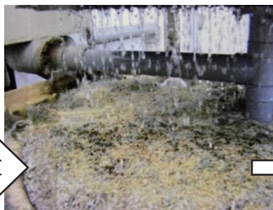
本製品を投入して施工中
