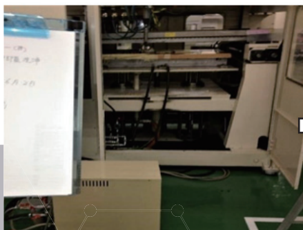
①金型成型機施工前
